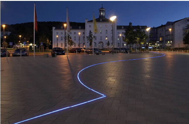
شكل 75. إضاءة LED مدمجة مع الأرضيات كتصميم خاص / كعلامة إرشادية لتحديد الطريق، ايزرلون، ألمانيا.
