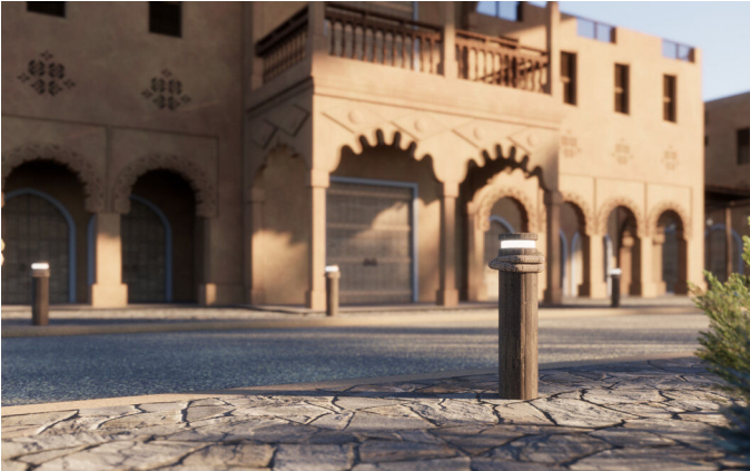
شكل 64. أعمدة إضاءة أرضية
