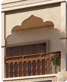
4 تستخدم الأقواس المدببة التي تميز الطرز المعماري لواحات الأحساء في تأطير وتظليل الشرفات
